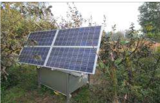
Panneau solaire alimentant le mécanisme de pompe (Crédit photo : G. Pasquier / AVENIR)
